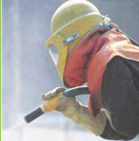
SABBIATURA E VERNICIATURA Sandblasting and painting Sandstrahlen und Lackierung
